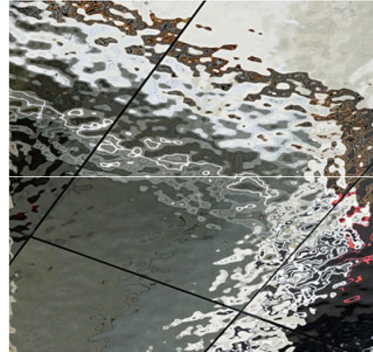
Plafond foyer water rippel metaalplaat
