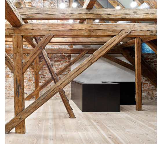
Dakconstructie monument in het zicht
